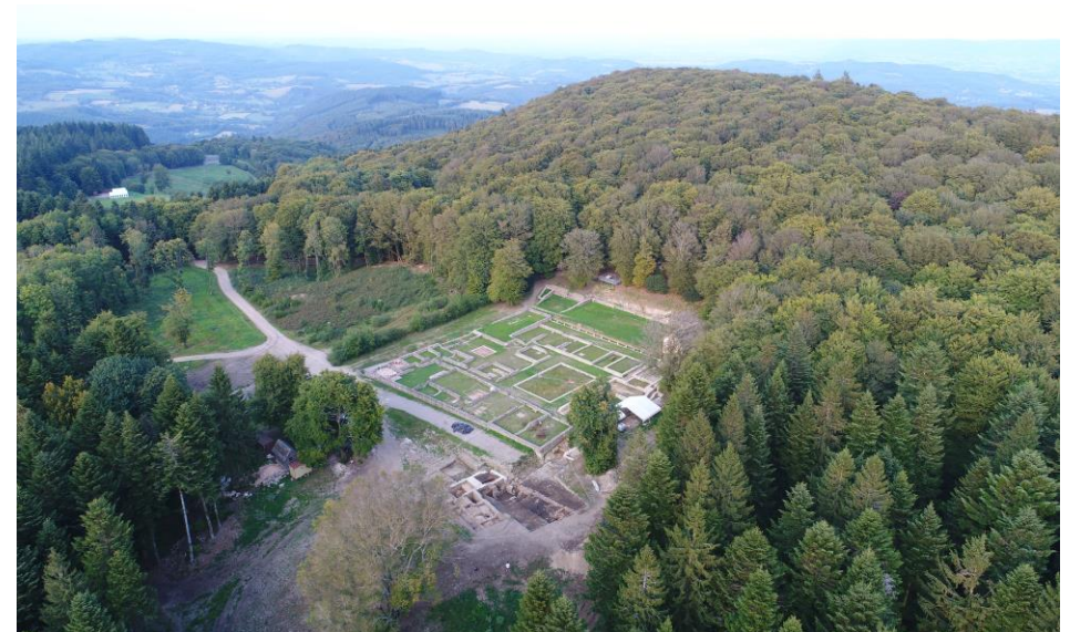
Vue du chantier en 2017 (cliché Bibracte 2015 – Q. Verriez n°111 755)
